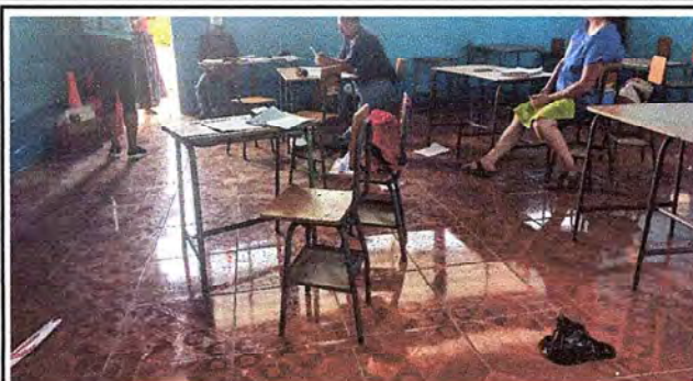
Foto 2: Se observa la remodelacion e instalación de piso cerámico en las tres aulas, direccion y la bodega en el modulo 1
