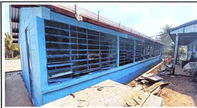
Foto 4: Se observa las ventanas y bases con nueva pintura en el modulo 1
