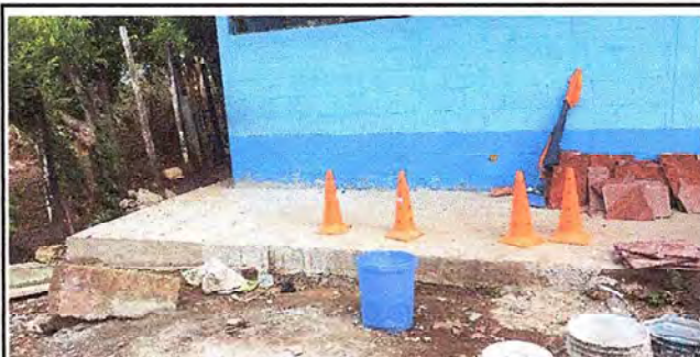
Foto 5: Se observa la nueva fundición del corredor dañado en el modulo 1
