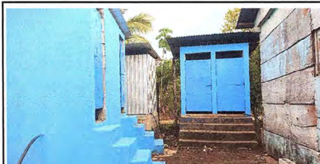
Foto 6: Se observa la bodega de letrina para niñas, remodelado con techos nuevos y piso reestablecido.
